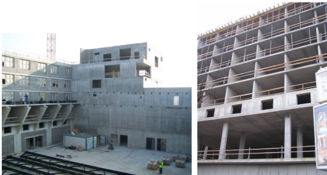
budova v průběhu výstavby
