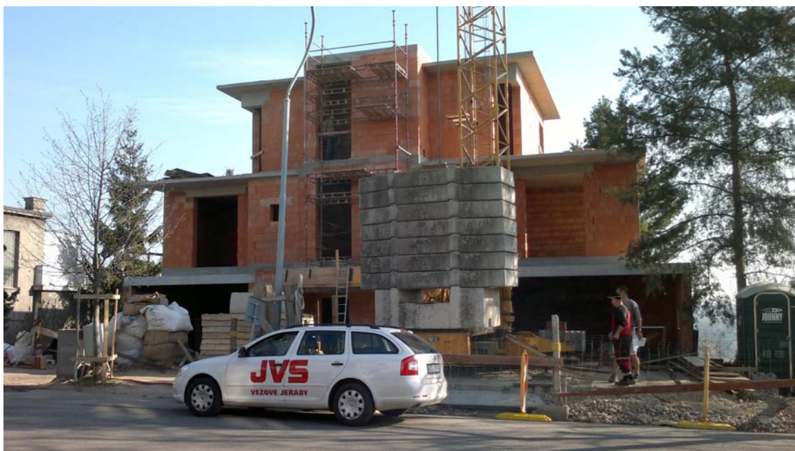
pohled z ulice v průběhu stavebních prací
