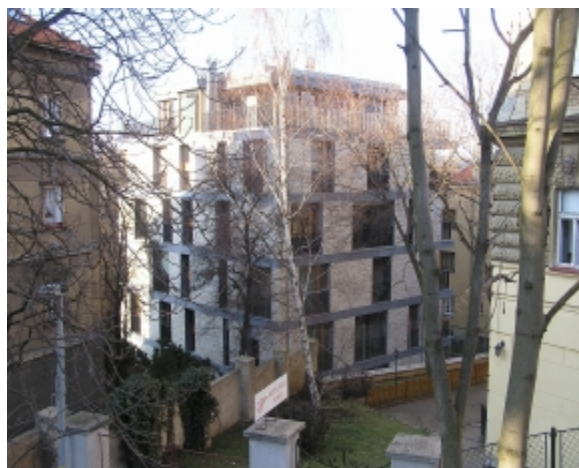
pohled na realizovaný objekt z ulice Na Václavce
