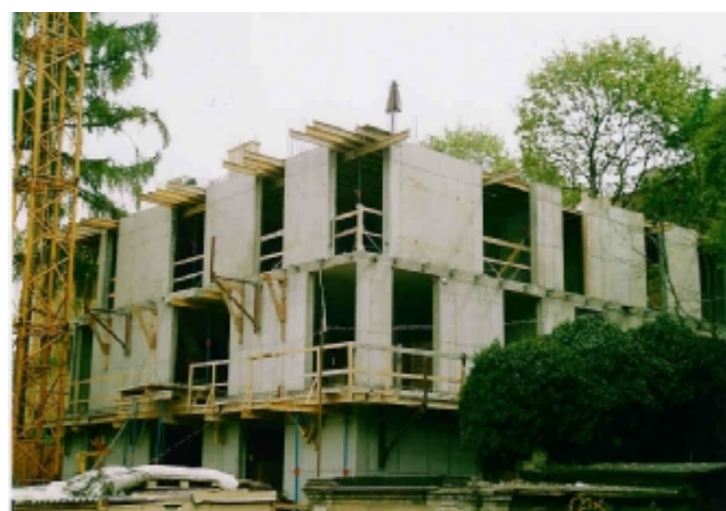
nosná konstrukce ve výstavbě
