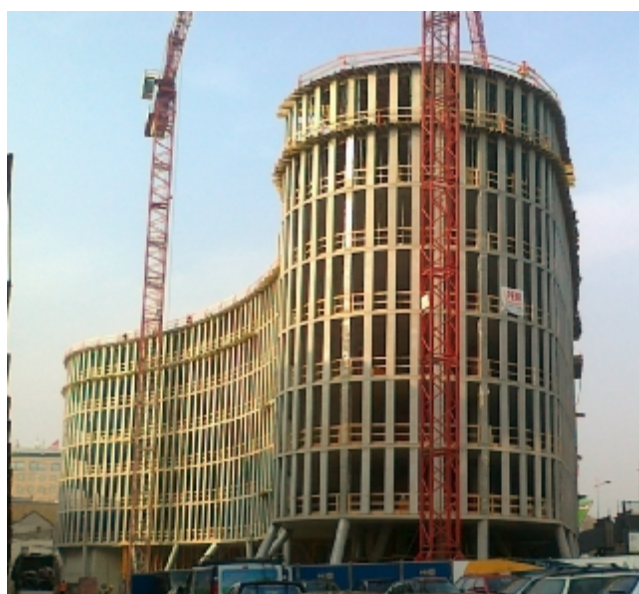
budova ve výstavbě
