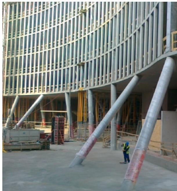
šikmé sloupy v přízemí - jeden z dominujících prvků
