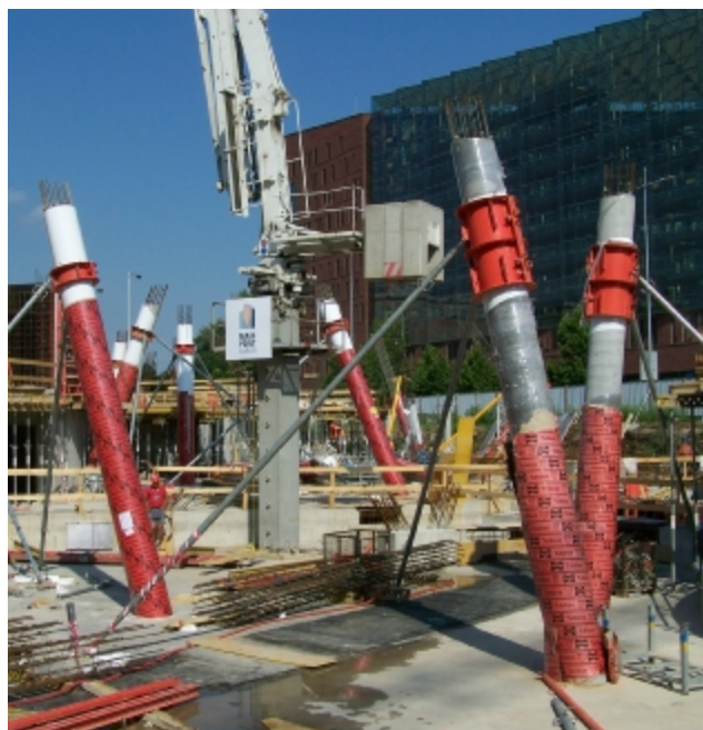
budování šikmých sloupů
