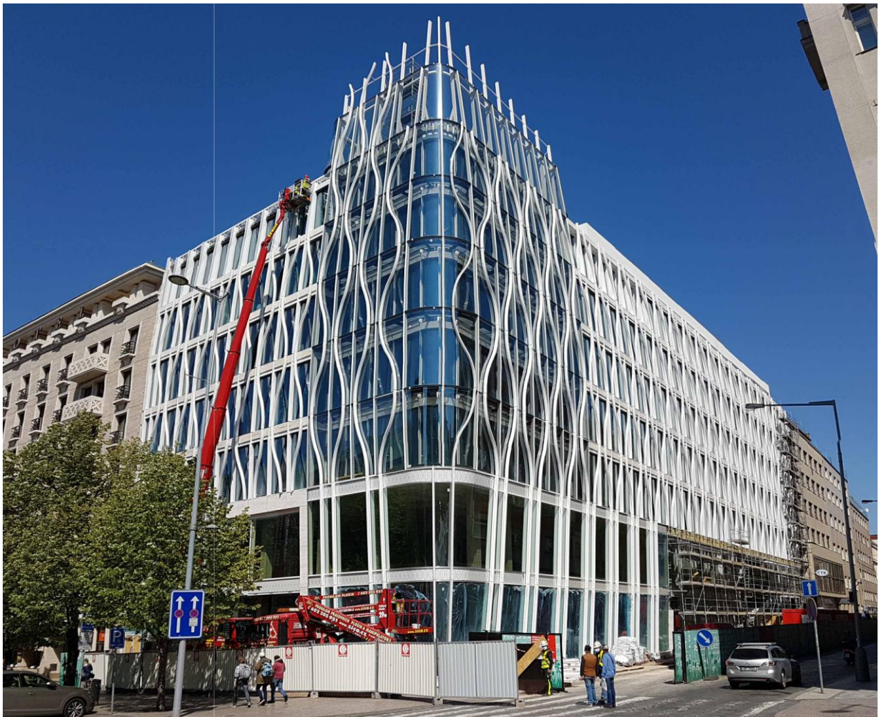
objekt v průběhu realizace
