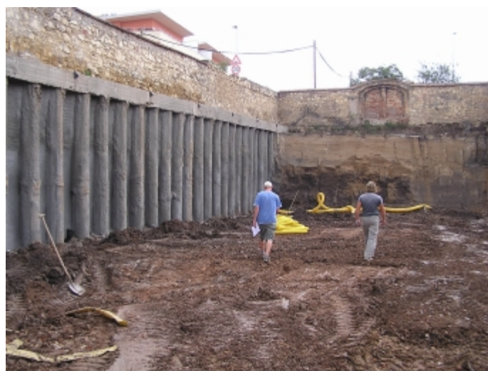
pilotová stěna zajišťující stavební jámu
