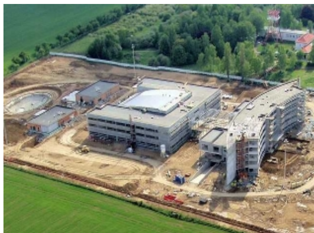
pohled na nosnou konstrukci objektu ve výstavbě
