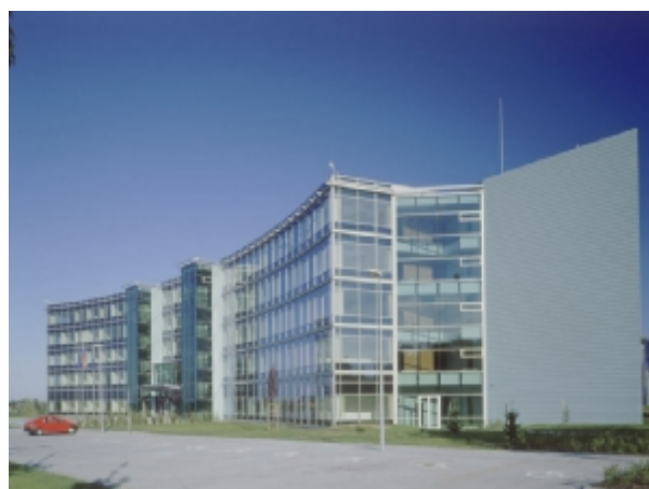
pohled na objekt z příjezdové komunikace
