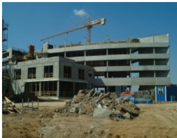
nosná konstrukce v částečné realizaci
