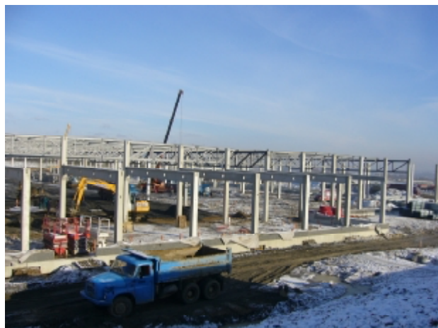
pohledy na nosnou konstrukci objektu ve výstavbě
