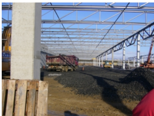
pohledy na nosnou konstrukci objektu ve výstavbě
