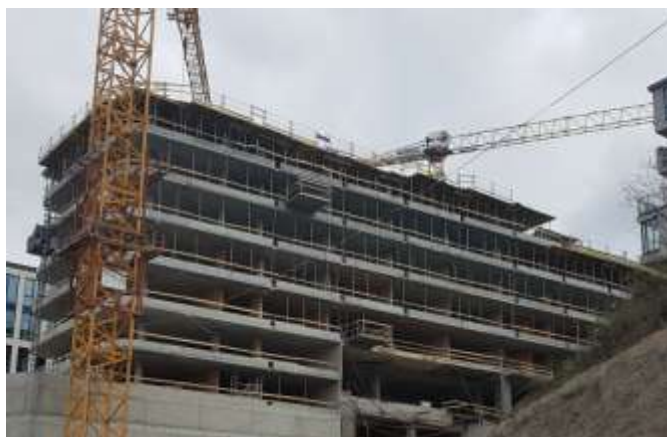
pohled na stavbu
