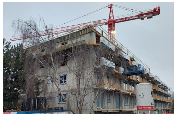
objekt v průběhu výstavby
