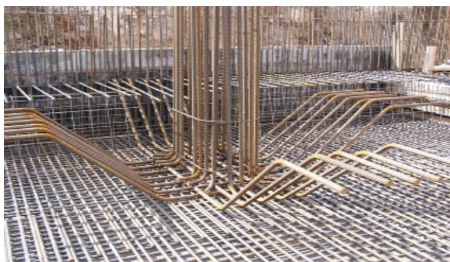
výztuž proti protlačení základové desky
