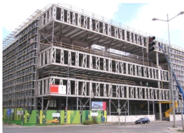
reálné foto v průběhu výstavby
