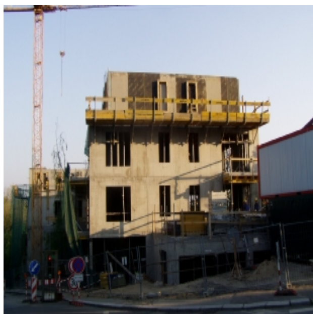
pohled na realizovanou hrubou stavbu
