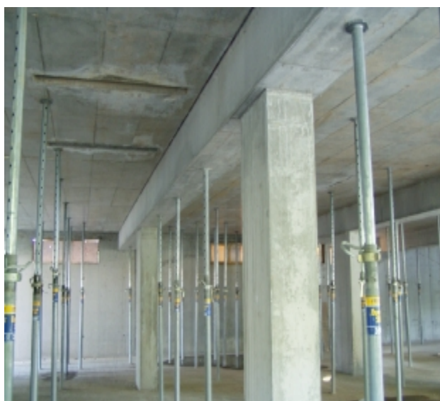
nosné konstrukce suterénu
