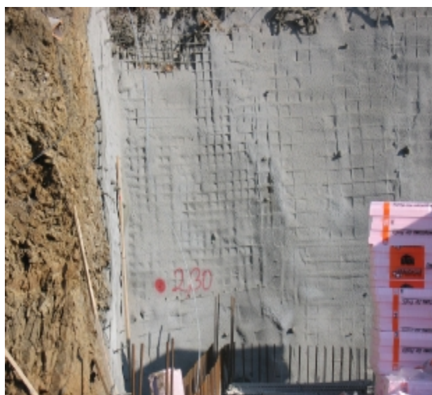
torketová stěna zajišťující stavební jámu
