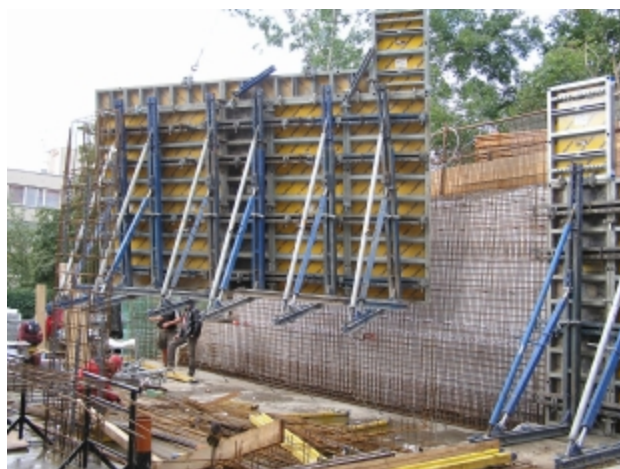
příprava před betonáží stěn
