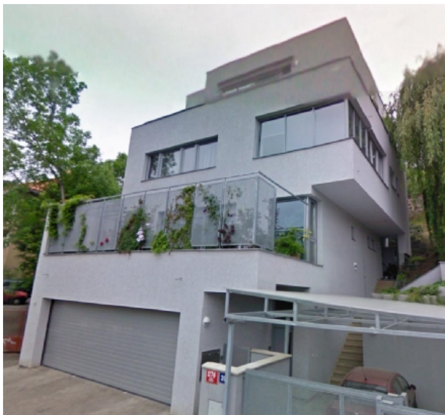
pohled na dokončený objekt
