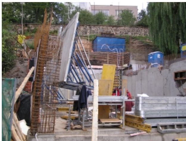
pohled do staveniště
