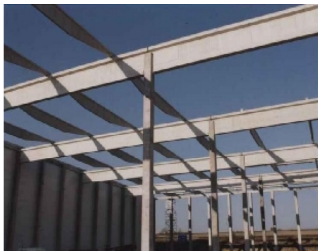
pohled na nosnou konstrukci objektu ve výstavbě
