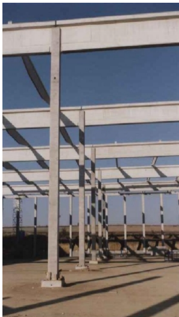
pohled na nosnou konstrukci objektu ve výstavbě
