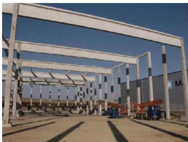
pohled na nosnou konstrukci objektu ve výstavbě
