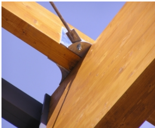
detail napojení krokví na vaznice
