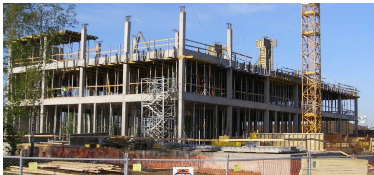
v průběhu výstavby
