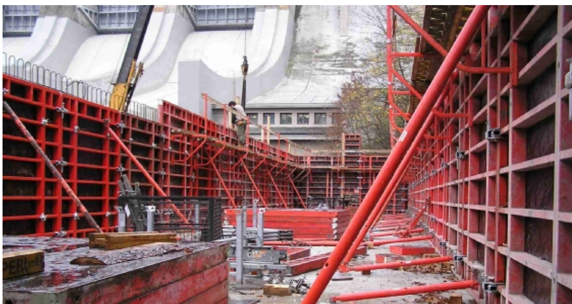
bednění při provádění stěn
