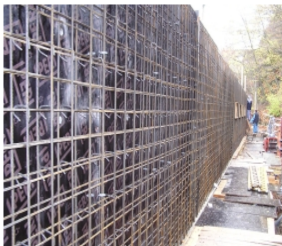
výztuž obvodové stěny
