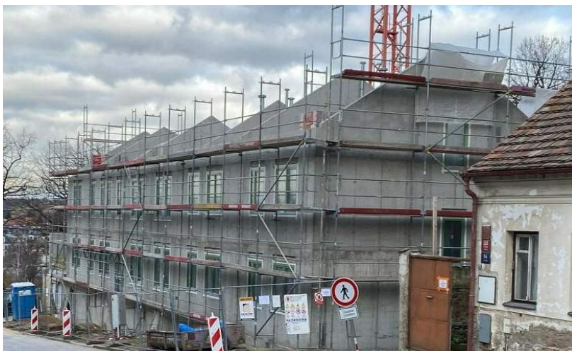
objekt v průběhu realizace
