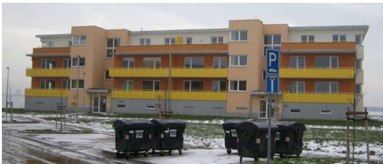
budova první etapy
