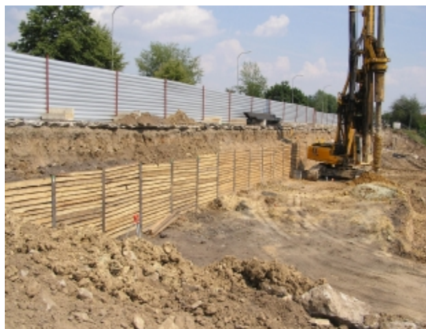
pohled na zajištění stavební jámy
