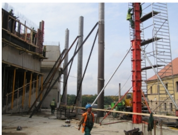
železobetonové sloupy budoucího skleněného atria
