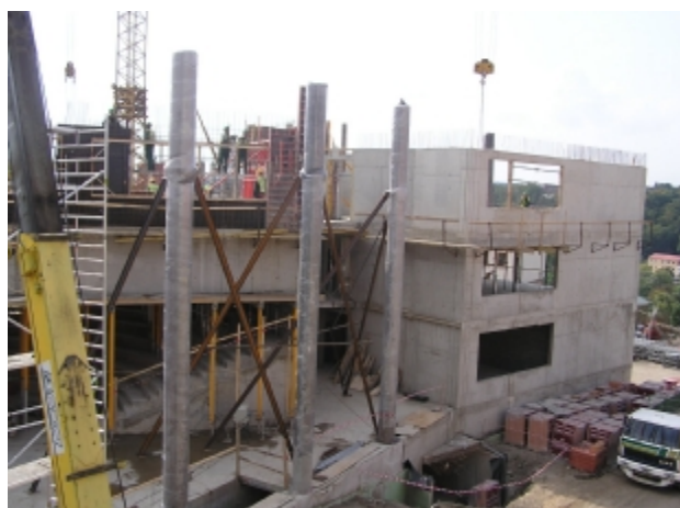
práce na novostavbě
