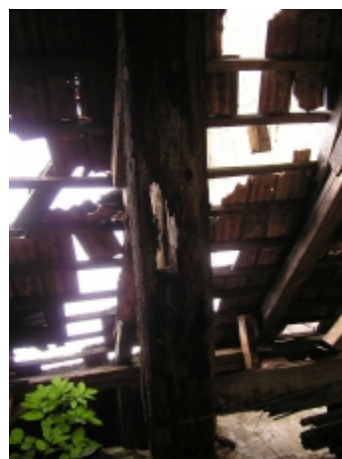
původní stav střešní konstrukce kláštera
