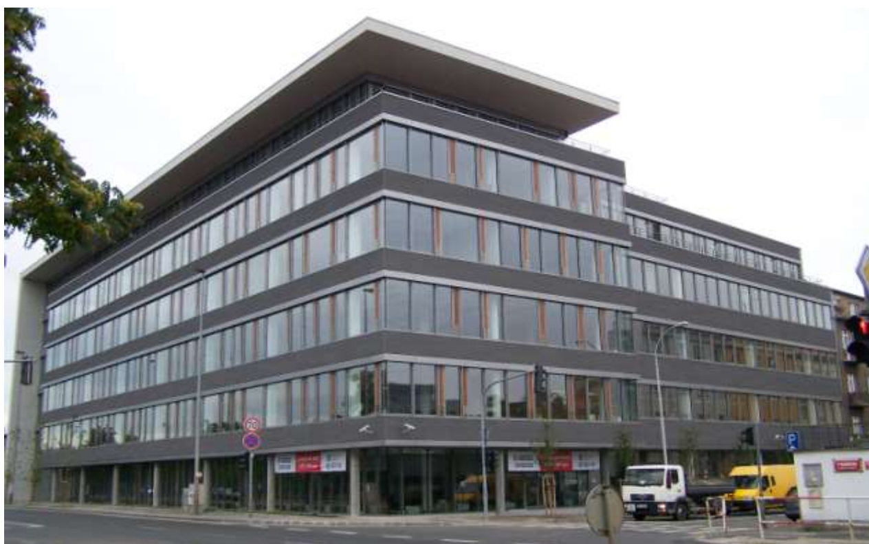
celkový pohled na budovu - nároží Strakonická - Moulíkova
