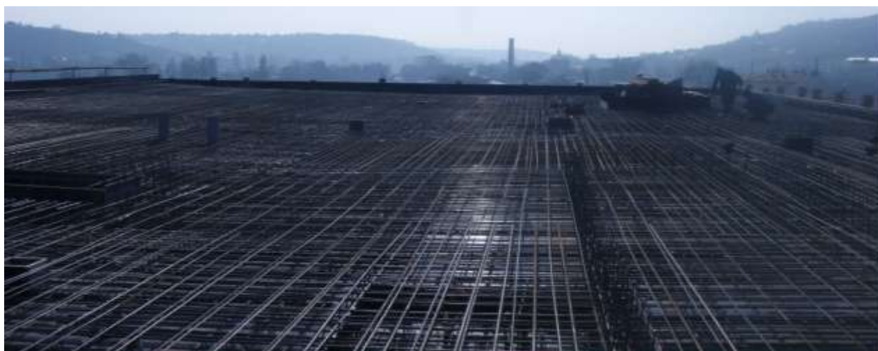
výztuž stropní desky před betonáží
