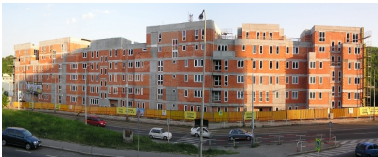
dokončení hrubé stavby
