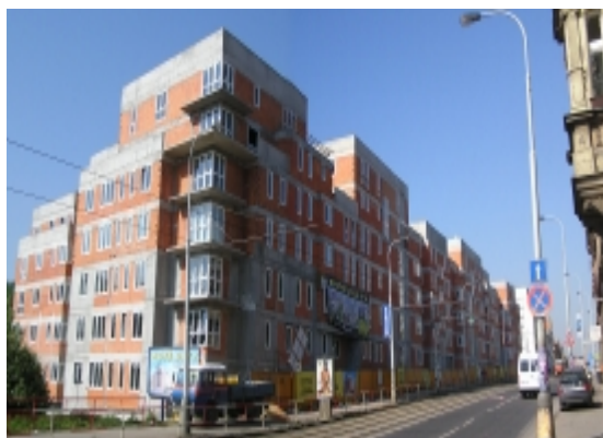
objekt ve stavbě - pohled od severovýchodu
