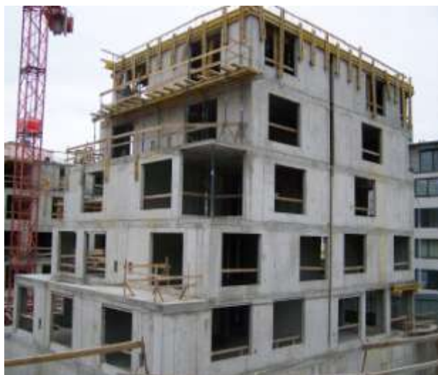
budova ve výstavbě
