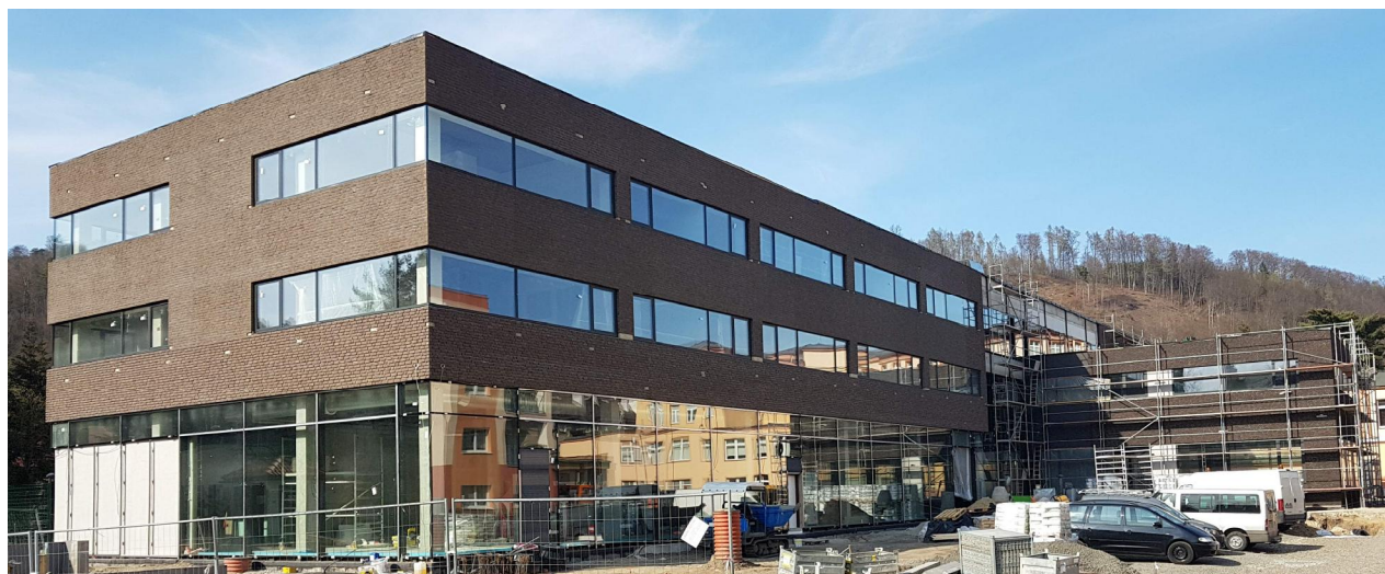
objekt v průběhu realizace
