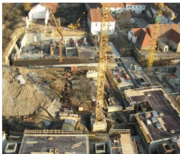
nosná konstrukce budovy ve výstavbě
