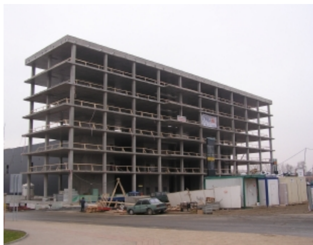
pohledy na nosnou konstrukci objektu ve výstavbě
