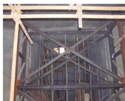
fotografie ze stavby
