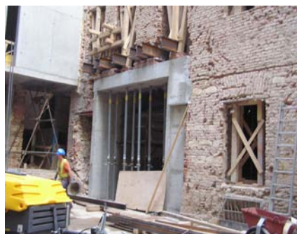
fotografie ze stavby
