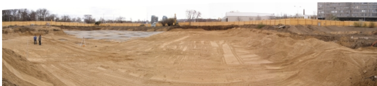
pohled na základovou spáru
