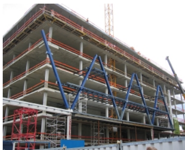
celkový pohled na montáž příhradového nosníku
