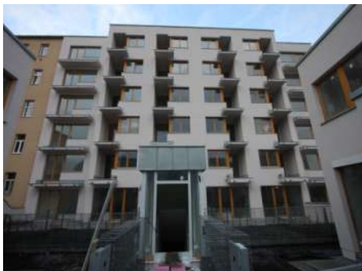
budova před dokončením – pohled z vnitřní dvorní vestavby
