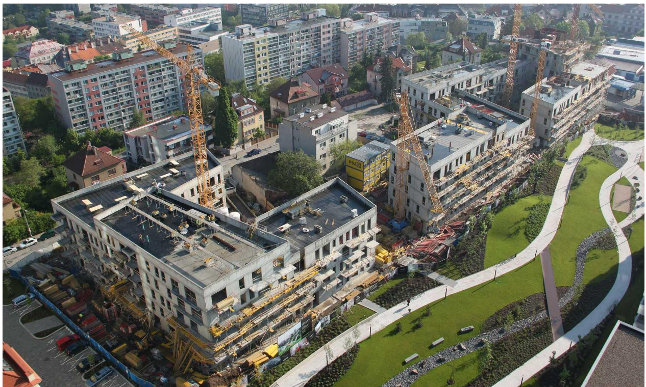
pohled na stavbu
