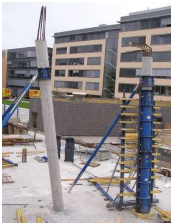
první šikmé železobetonové sloupy v Čechách
