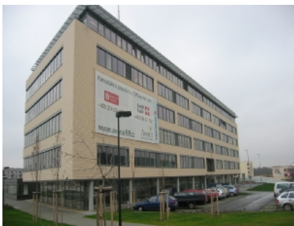
pohled na realizovaný objekt od Radlické ulice
