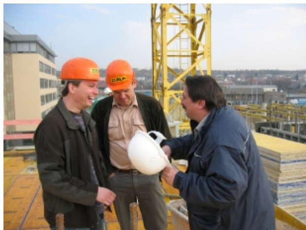
pracovní diskuze na bednění stropní desky
