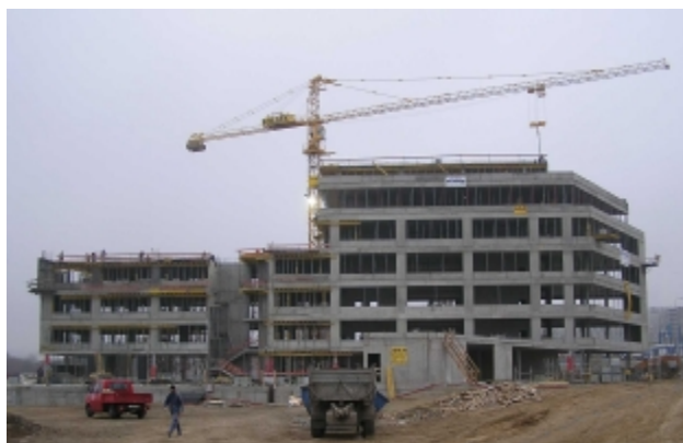
nosná konstrukce etapy I ve výstavbě
