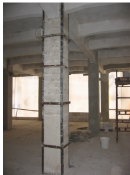
odhalené konstrukce betonového skeletu
