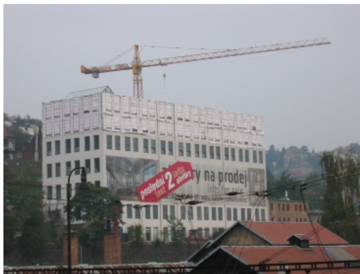
pohled na rekonstruovanou budovu s nástavbou v realizaci
