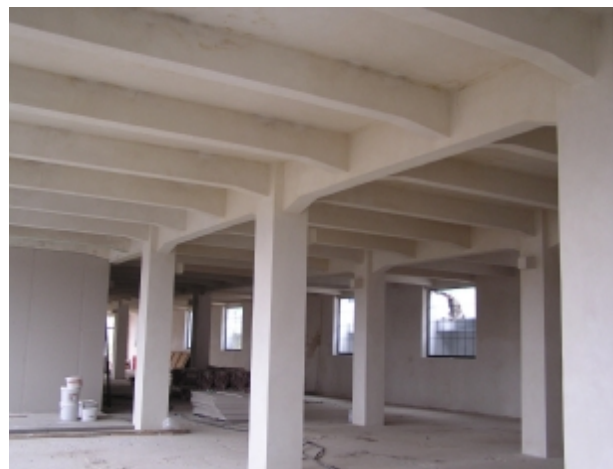
nosné konstrukce typického podlaží
