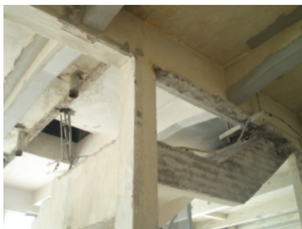
odhalené konstrukce betonového skeletu
