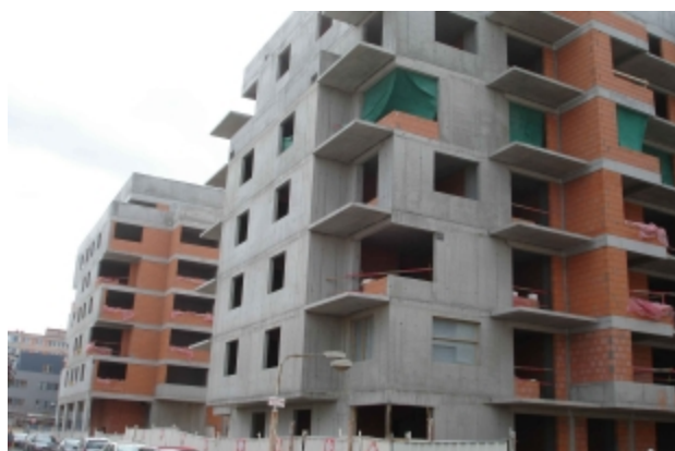
pohledy na hrubou stavbu
