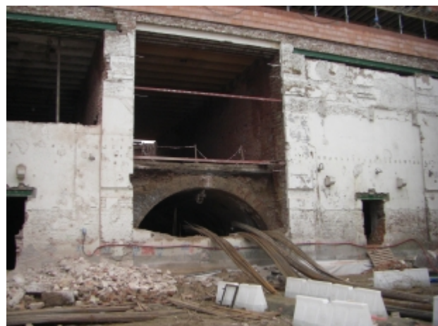
rekonstrukce stávajících objektů
